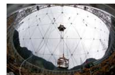
索网结构 Cable-net structure
